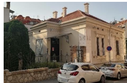
Слика 10. Дом Јована Цвијића, 2021. година, видљива реконструкција спољашњости, али задржан изглед из 1979. године, фото ДРИ
